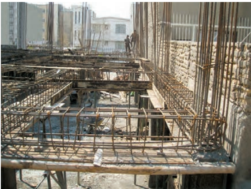
تصویر ۱۲ - نحوه‌ی قرارگیری آرماتورهای کلاف‌های بتنی
