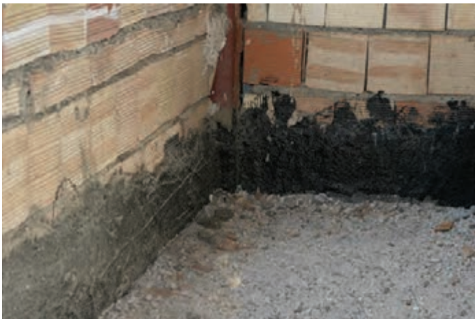
تصویر ۱۶ - عایق‌کاری کف سرویس بهداشتی
