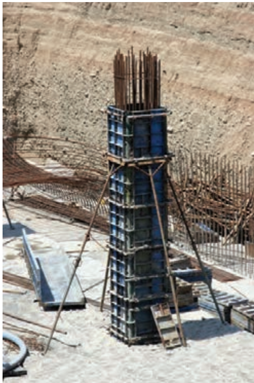
تصویر ۴ - قالب‌بندی فلزی ستون
