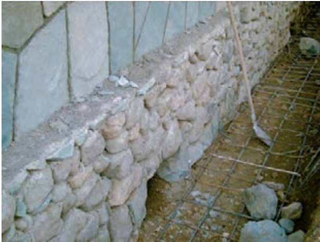
تصویر ۱- پی و دیوار سنگی
