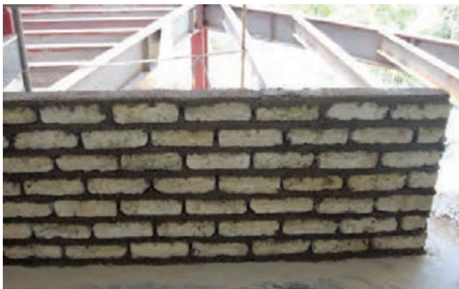
تصویر ۱۴ - دیوار نیم آجره (۱۱ سانتی‌متری)
