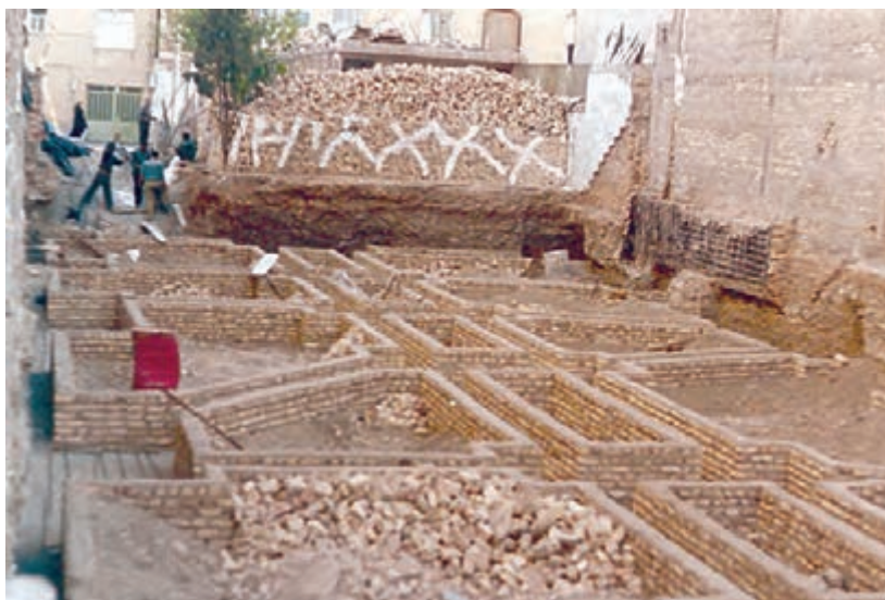
تصویر ۵ - قالب بندی آجری بی ساختمان
