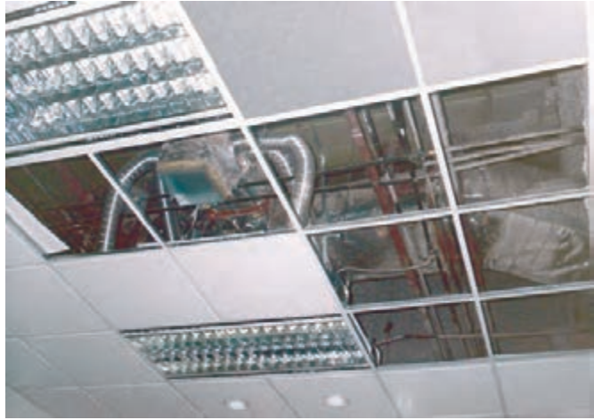
تصویر ۲۰ - زیر سازی سقف کاذب
