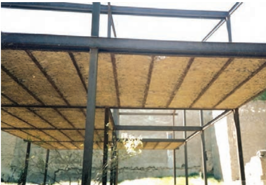
تصویر ۱۰ - تیرریزی سقف طاق ضربی
